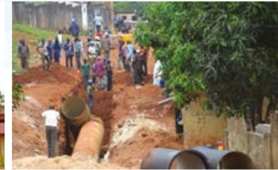
Travaux de raccordement d'une conduite DN 1100 en fonte
